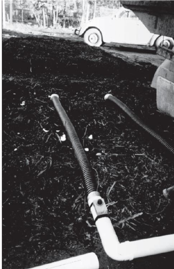
Figura 13.18: Montagem da base de leira estática aerada, observando-se a instalação do termostato que aciona a aeração.
