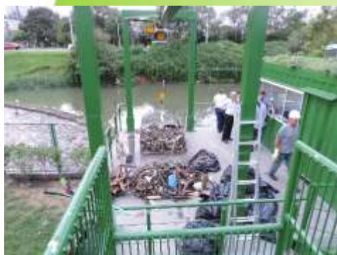
Fig. 4: Retirada de resíduos para disposição em aterro
